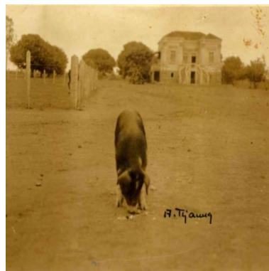
Figura 01: Vista do Castelinho
